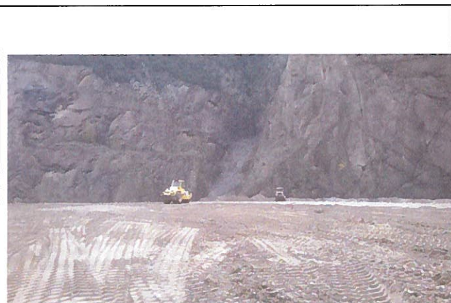
11. Bull et compacteur sur la plateforme
