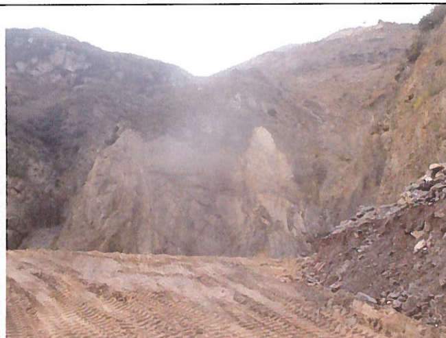
10. Matériaux grossiers contre le front rocheux, matériaux fins et hétérogènes sur la plateforme
