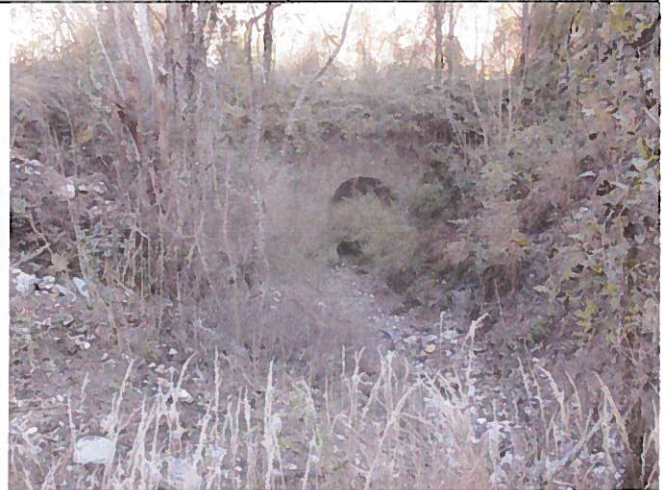
8. Buse sous le RD6202
