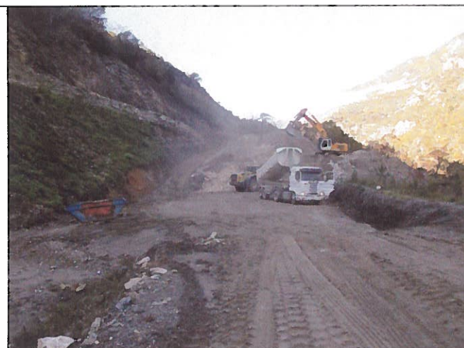
9. Zone de déchargement et de reprise
